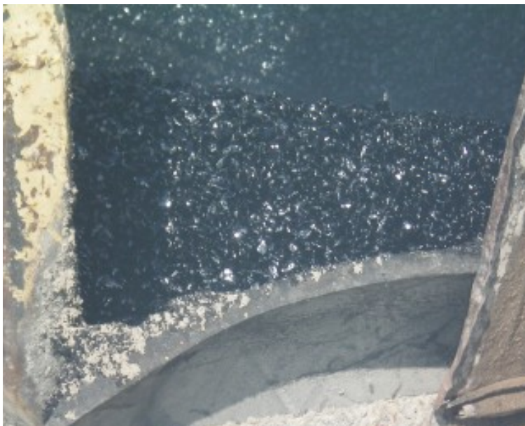
Фото 6. Вид смеси в бункере асфальтоукладчика.
