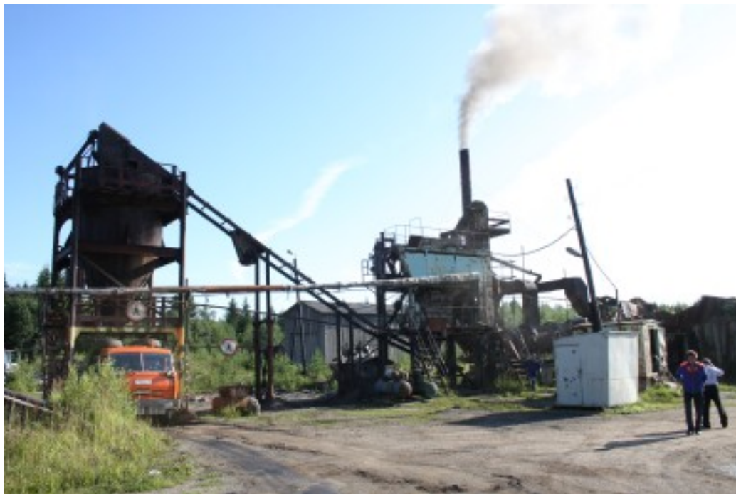
Фото 3. Общий вид АБЗ.
