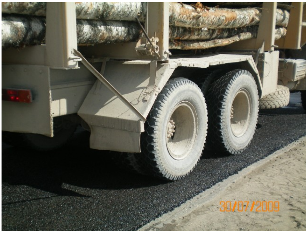
Фото № 10. Движение транспорта было открыто сразу после уплотнения смеси.
