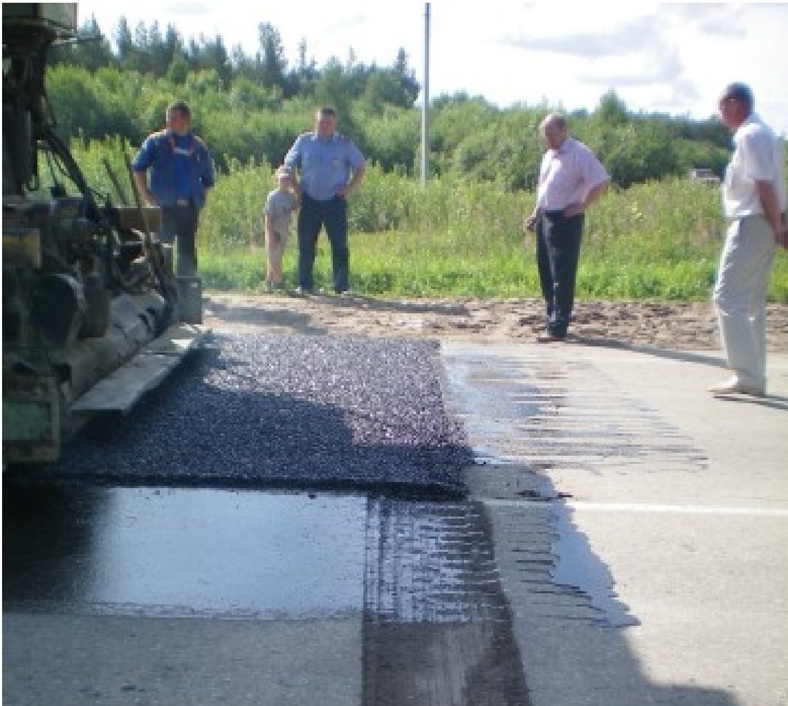
Фото 7. Начало укладки ШТП.
