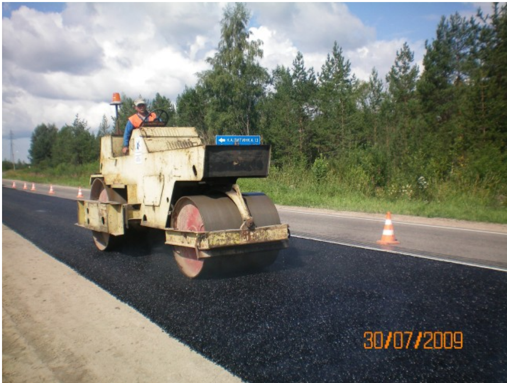
Фото № 9. Уплотнение шероховатого тонкослойного покрытия.
