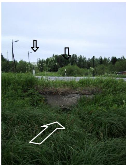
Рисунок 7. Водопропускная труба, обозначенная маркерами
