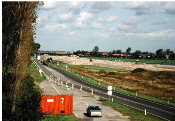
Заблаговременные земляные работы до строительства – прибавьте 3 года
