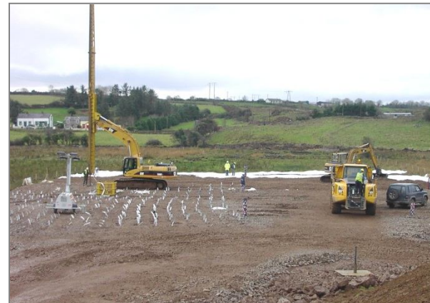
Вертикальный дренаж для скоростной осадки – прибавьте €€€€€
