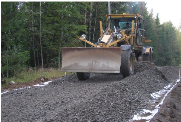
Восстановление дороги на торфе Дополнительная нагрузка – дополнительная осадка
