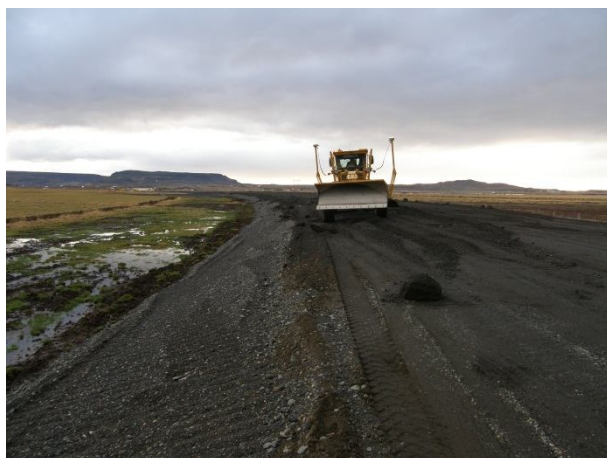
2-полосная дорога в Исландии, построенная методом пригрузки– 1 год
