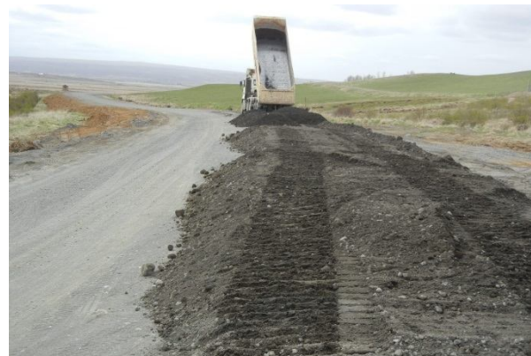
Уширение дороги на торфе Как гармонизировать работу существующего и нового участка
