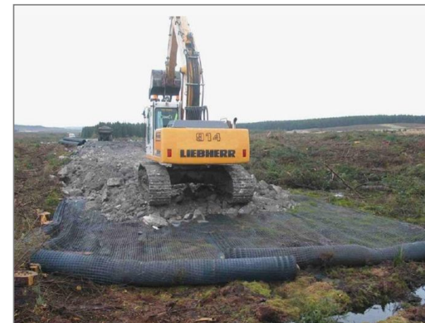
Низкоинтенсивная дорога к ветрякам – немедленная нагрузка 150т грузовиками
