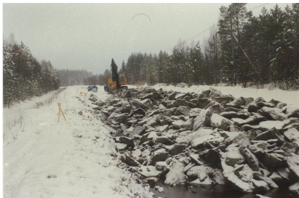
Планирование работ – выторфовка промерзшего торфа зимой
