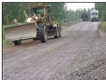
Усиление дорожной конструкции
