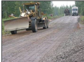
Усиление дорожной конструкции
