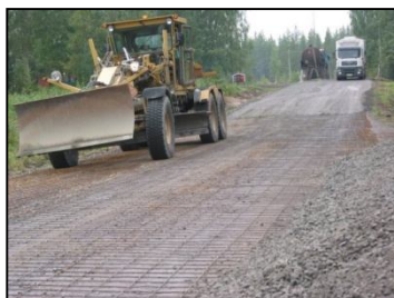
Усиление дорожной конструкции
