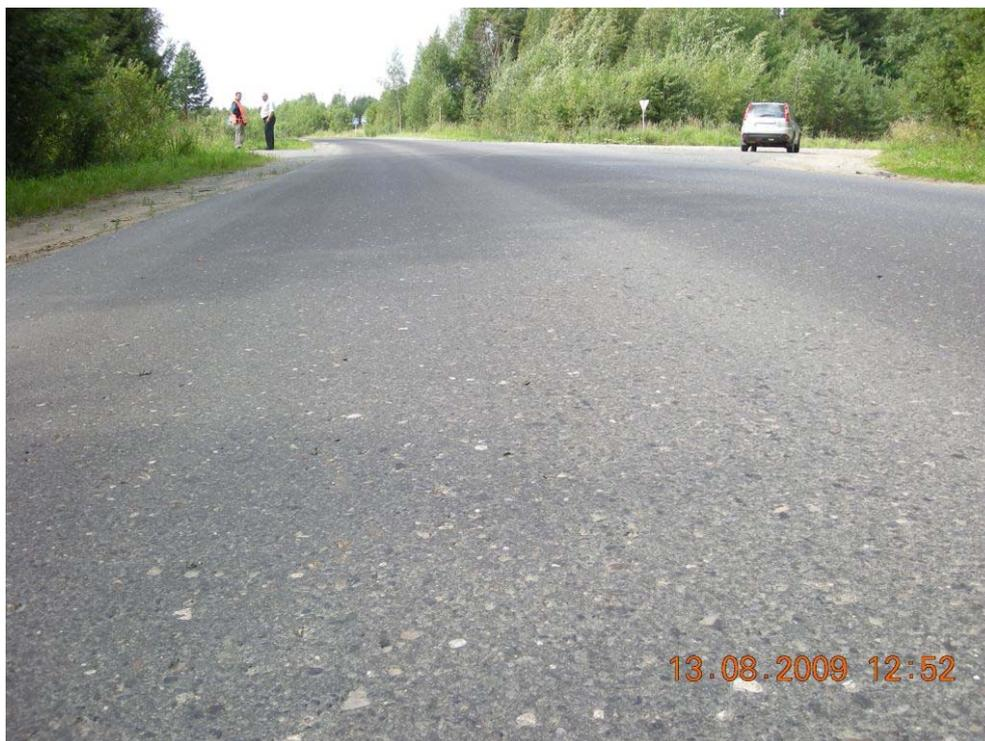
Представленная картина говорит об эффективности "Битрэка", так как производителем одним из главных достоинств этой добавки была указана именно высокая трещиностойкость итогового покрытия. Предлагается закончить мониторинг данного экспериментального участка и рассмотреть возможность применения данного материала в южных районах Архангельской области.
