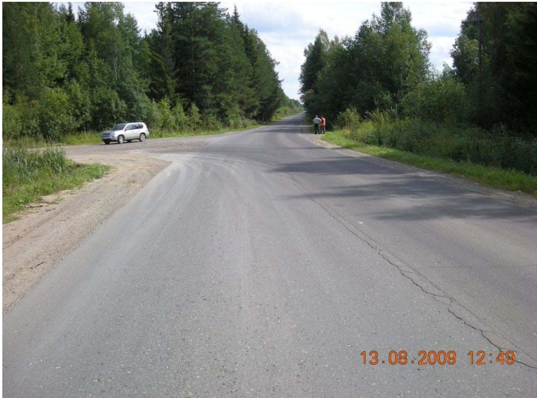
В отличие от участка без применения "Битрэк" на 300 м эксперимента через 3 года после его проведения появления трещин, сеток трещин и тп не наблюдается
